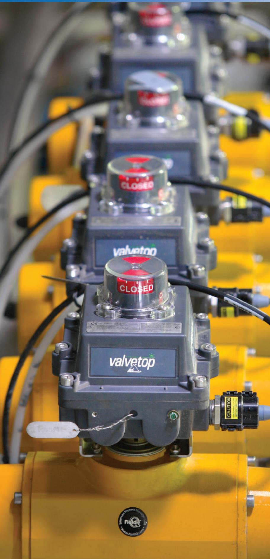
I regolatori per valvole discreti Valvetop™ consentono alle valvole di controllo automatizzate di comunicare tramite i protocolli FOUNDATION Fieldbus, DeviceNet, AS-Interface, Profibus, HART e Wireless HART. Si collegano a tutte le valvole e agli attuatori rotativi e lineari, funzionano nelle condizioni ambientali più esigenti e vantano una grande varietà di certificazioni per aree pericolose.
